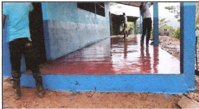
Foto 1: Aula No. 1 Corredor de las dos aulas. Se observa la reparación del piso de tierra por piso de torta de concreto con alisado.
