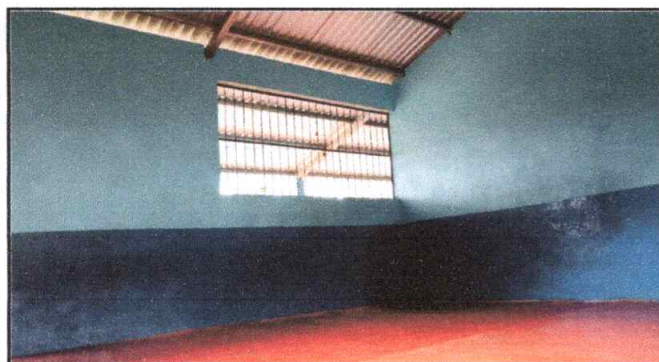
Foto 3: Aula No. 1 Se observa el interior del aula, se realizó el repello de paredes interiores y exteriores con aplicación de pintura.
