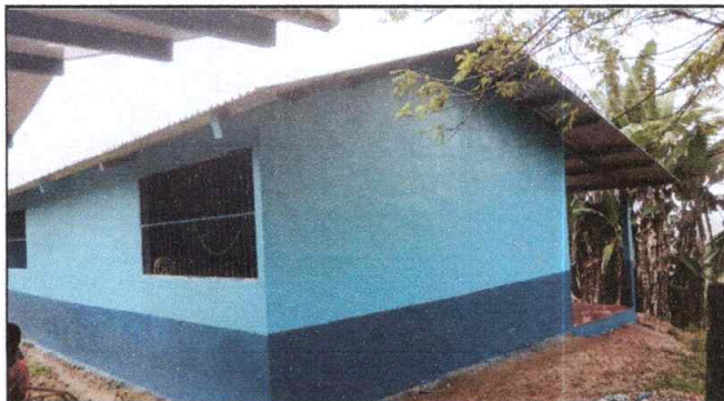
Foto 2: Aula No. 2 en la parte de atrás de las dos aulas. Se observa el repello en paredes y la aplicación de pintura en muros interiores y exteriores.
